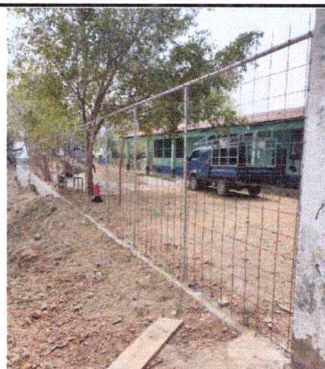
Foto 2: Vista del perímetro que se remozó.
