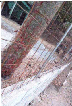
Foto1: Se observa la estructura metálica que se empleó para la circulación del perímetro del establecimiento.
